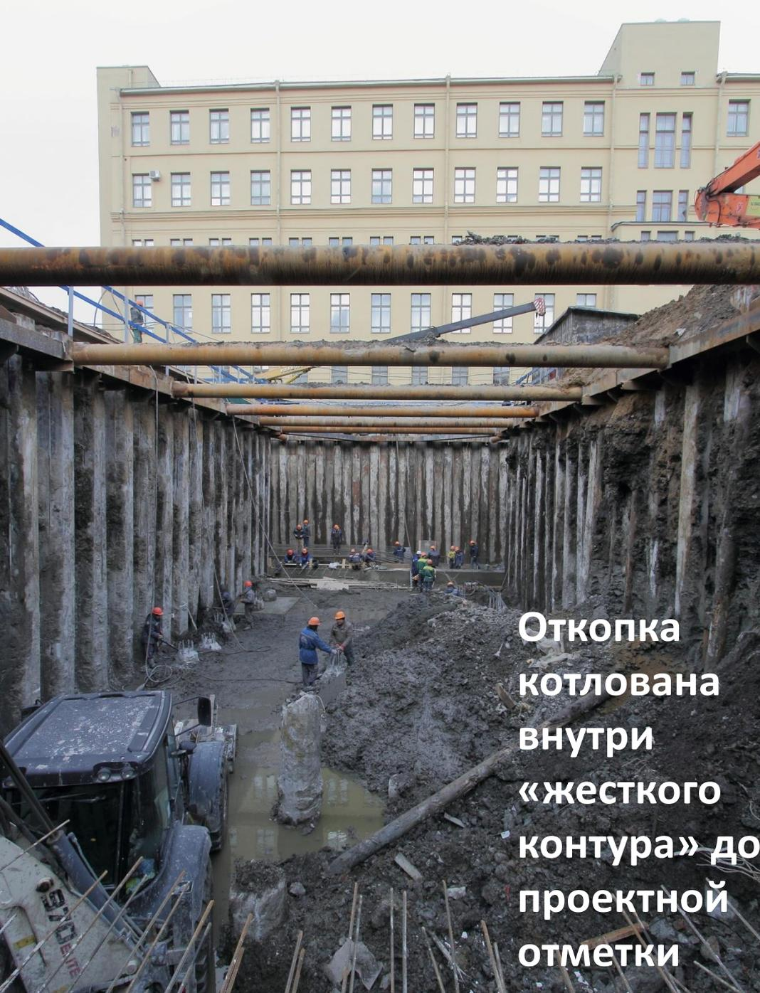
Откопка котлована внутри «жесткого контура» до проектной отметки
