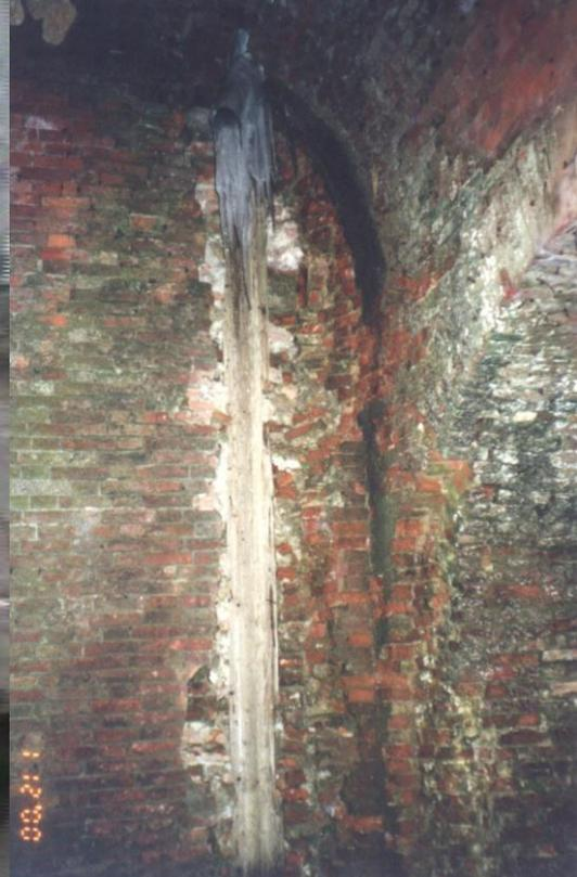
Неисправная система водоотведения, предусматривающая сброс воды с террасы через конструкции подпорного сооружения, привели к его разрушению
