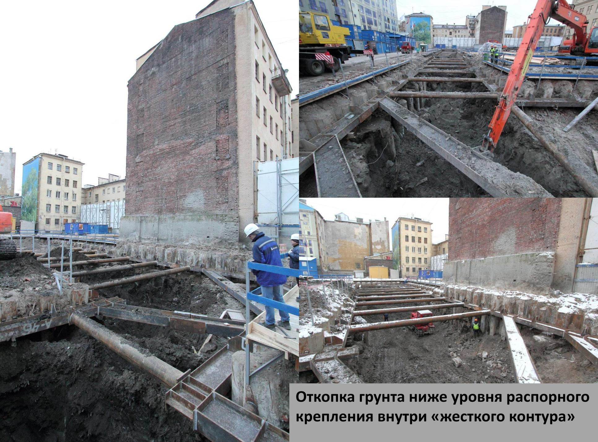
**Откопка грунта ниже уровня распорного крепления внутри «жесткого контура»**
