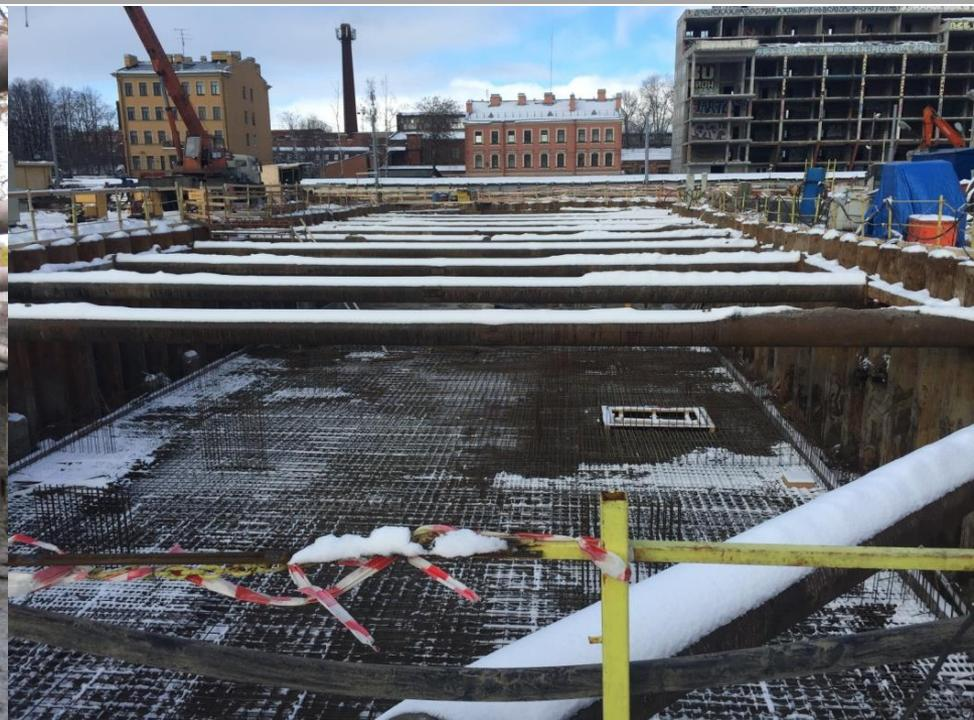
**Пример ошибочного решения ограждения котлована (не обеспечено восприятие горизонтальных усилий системой распорок), который привел к аварийному разрушению прилегающего исторического здания**
