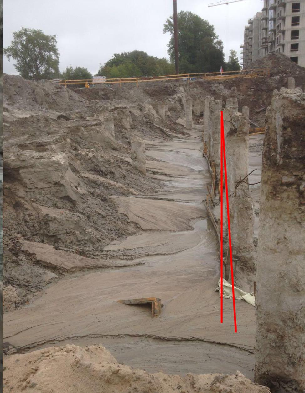
При откопке котлована с временными откосами 1:2 происходит наклон и смещение свай (до 1 м)
