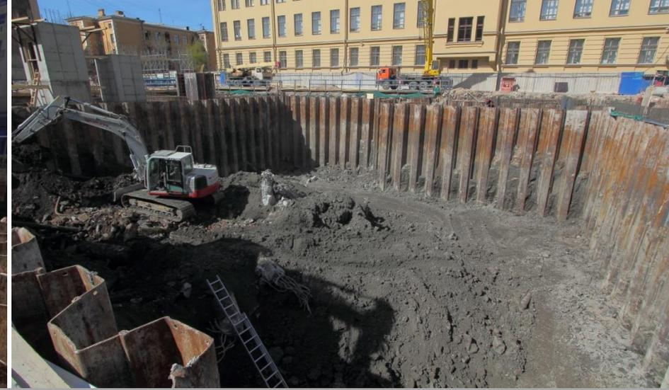
Откопка грунта внутри «островов» и виброизвлечение шпунта
