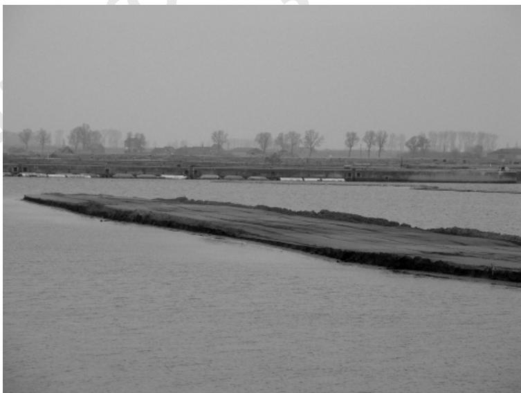
Рис. 9.3. Вершина насыпи начинает выступать из-под воды (январь 2006 г.)
