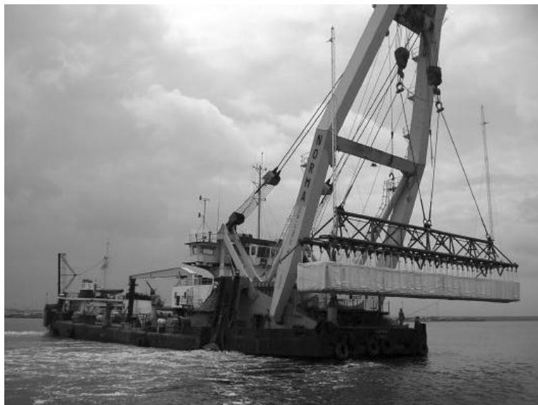
Рис. 9.2. Размещение геоконейнеров
