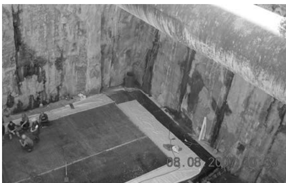
Рис. 9.21. Участок ramпы Орловского тоннеля.
