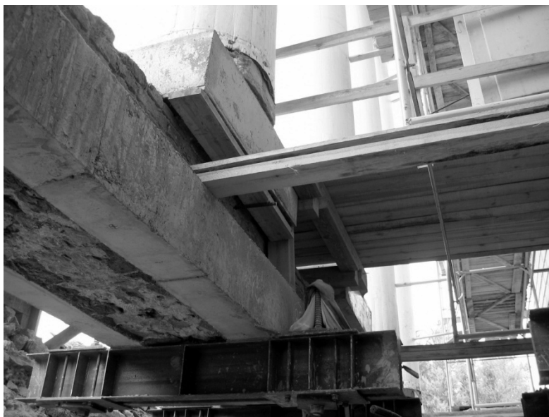
Рис. 9.77. Вся нагрузка передана на сваи. Старые фундаменты разобраны
