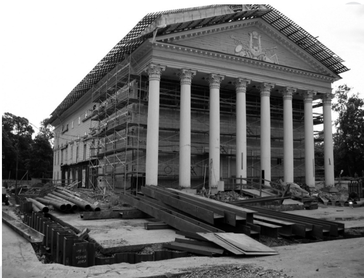
Рис. 9.70. Каменноостровский театр. Начало реконструкции.
