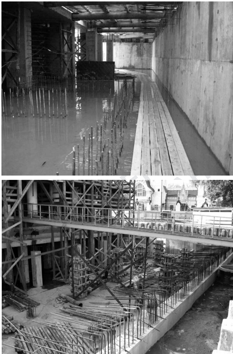
Рис. 9.84. Устройство конструкций подземного сооружения
