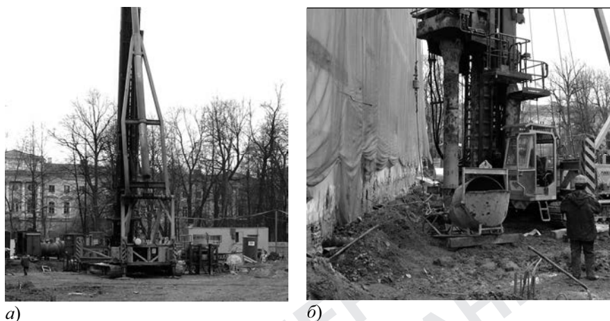
Рис. 8.14. Изготовление свай по технологии «Fundex»: а – общий вид установки; б – изготовление свай у межевой стены соседнего дома на площадке 3
