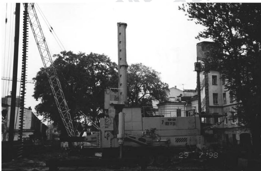
Рис. 8.1. Сваевдавляющие установки треста № 101 (верхнее фото) и УСВ120 М (нижнее фото).
