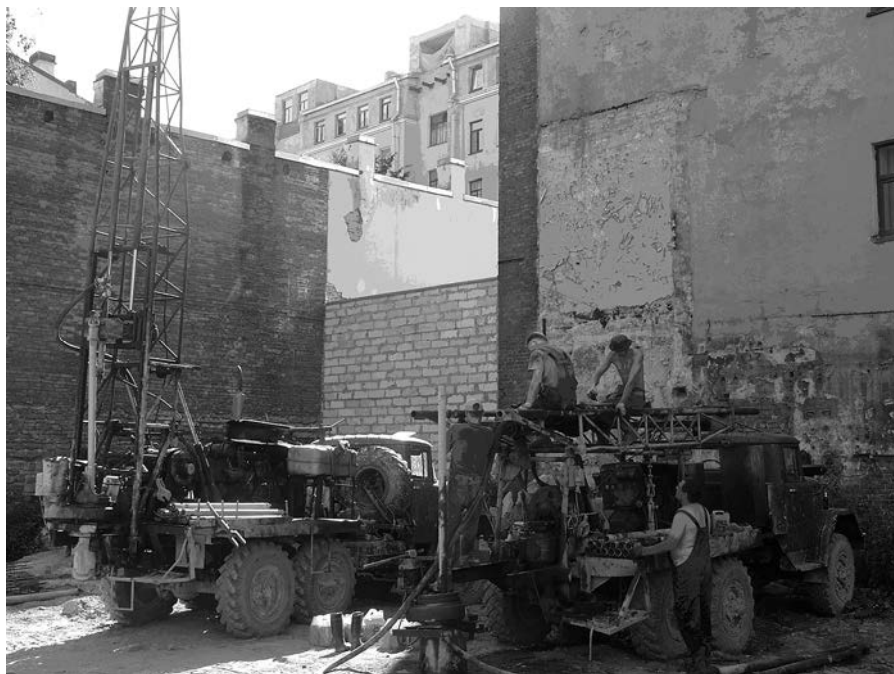
Рис. 8.26. Изготовление свай под защитой «бурового раствора» на площадке 9
