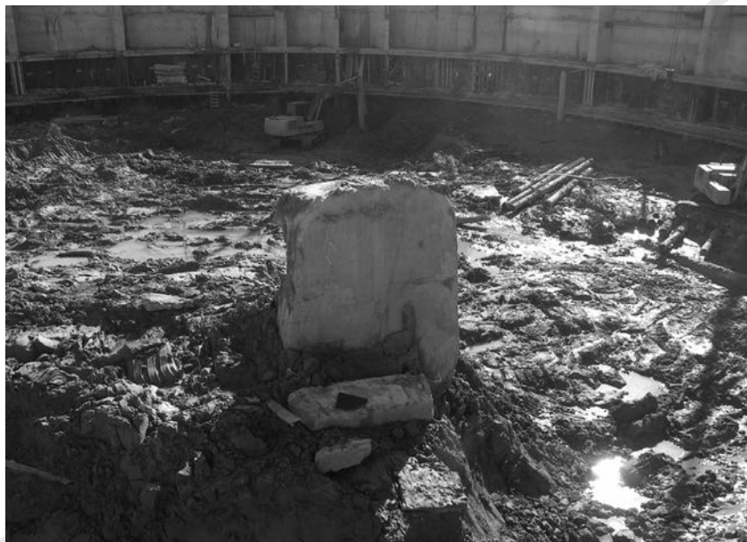
Рис. 9.20. Опытная захватка железобетонной стены в грунте в процессе откопки
