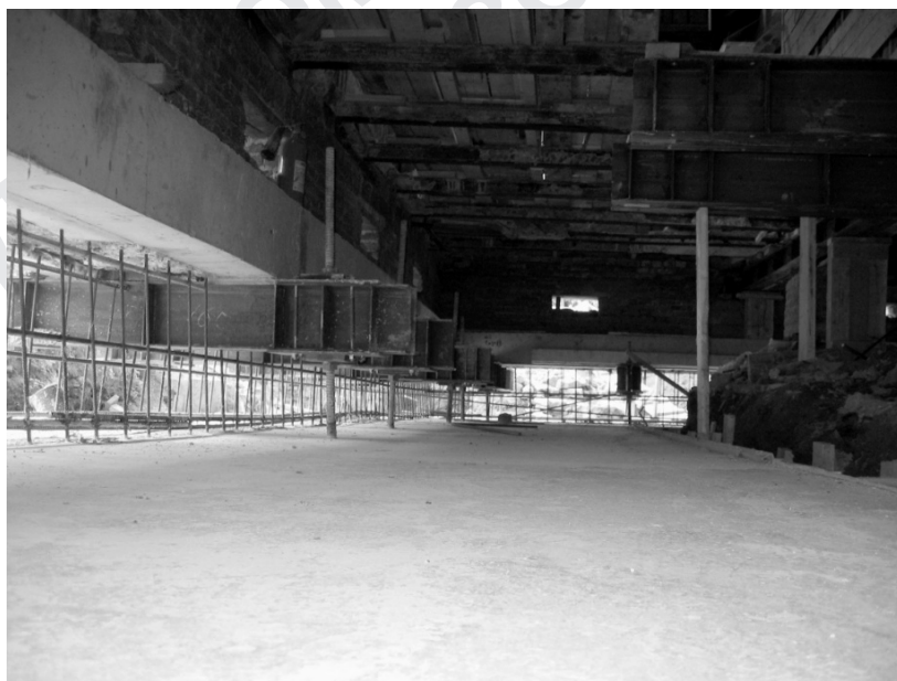
Рис. 9.79. Устройство верхней плиты на отметке минус 2 м
