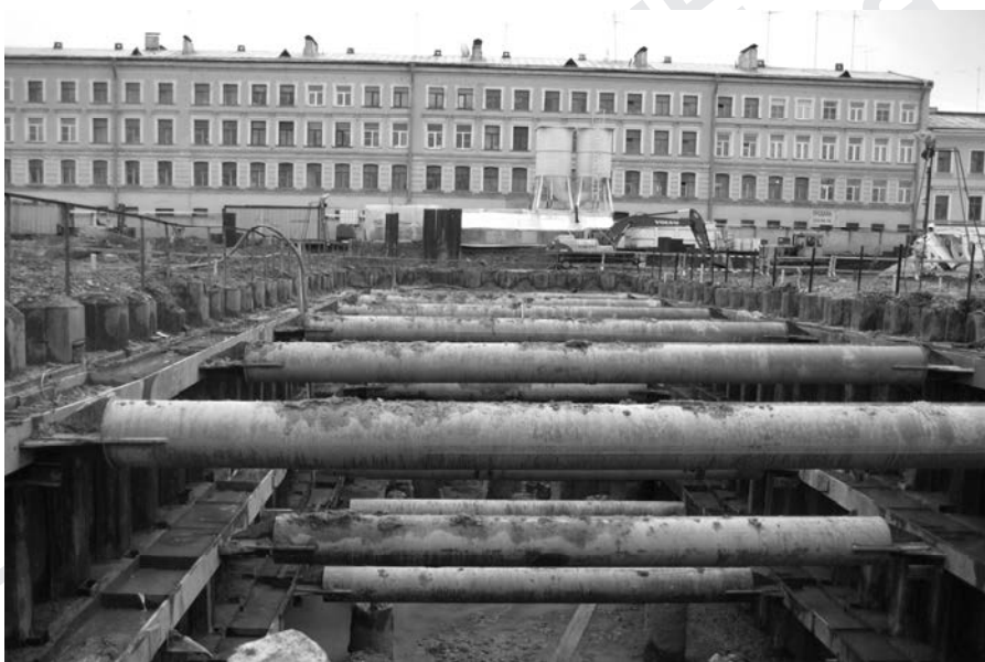
Рис. 9.38. Общий вид опытной площадки на территории строительства Второй сцены Мариинского театра
