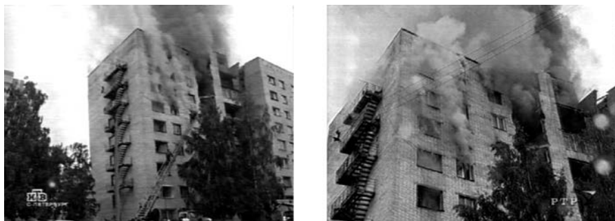
Рис.5.29. Общий вид деформирования здания перед разрушением (кадры из видеозаписи)
