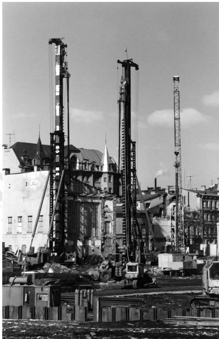
Рис. 8.29. Общий вид установки «CFA» с многолопастным шнеком.
