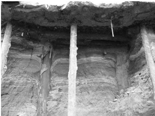
Рис. 9.82. Характерное очертание прослоев грунта возле исторической деревянной сваи
