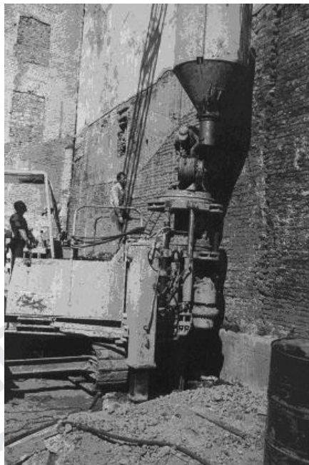
Рис. 8.17. Применение технологии «Atlas» на площадке 5: а – общий вид установки; б – изготовление свай у межевой стены соседнего здания
