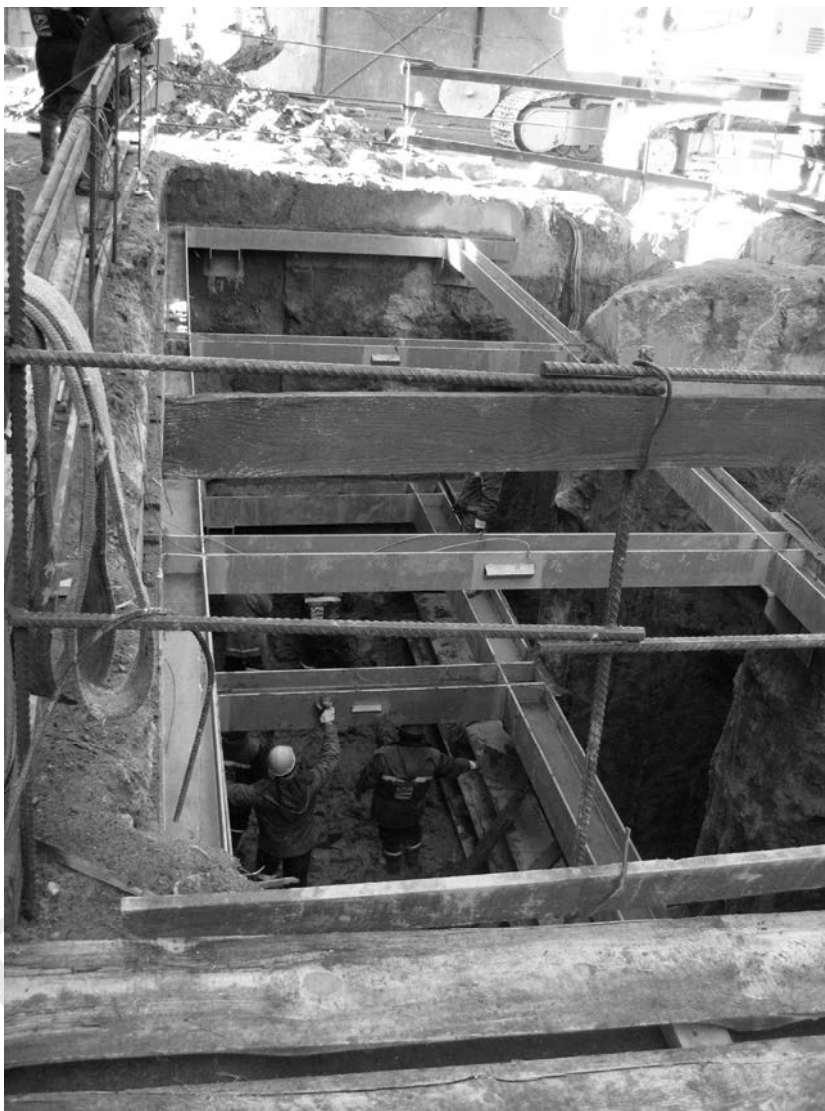
Рис. 9.23. Вид опытной площадки после откопки котлована (Санкт-Петербург, Зоологический пер. 2-4)
