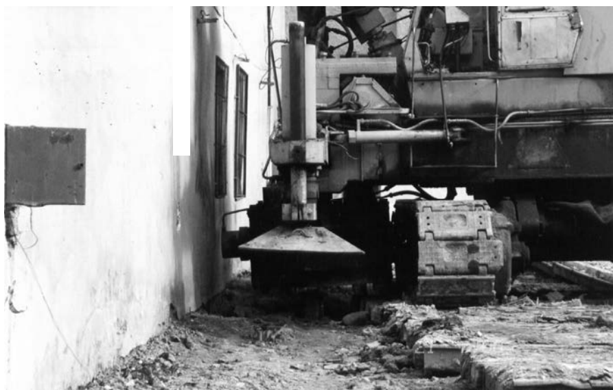
Рис. 8.8. Вдавливание шпунта вдоль межевой стены существующего дома на площадке 2
