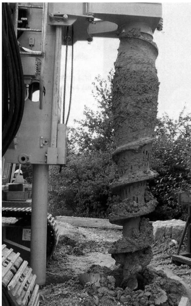
Рис. 8.19. Устройство свай по технологии DDS.
