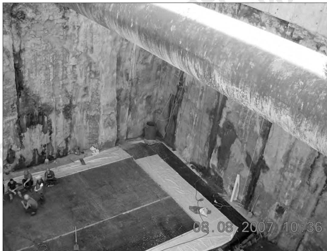
Рис. 4.1. Участок ramпы Орловского тоннеля
