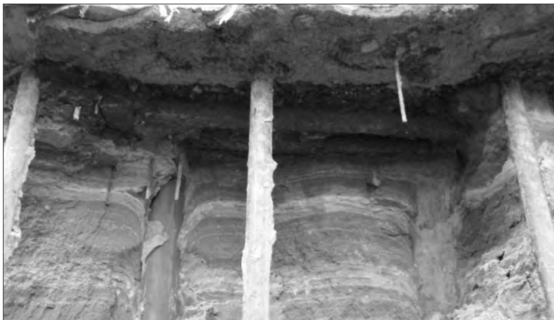
Рис. 9.13. Характерное очертание прослоев грунта возле исторической деревянной сваи
