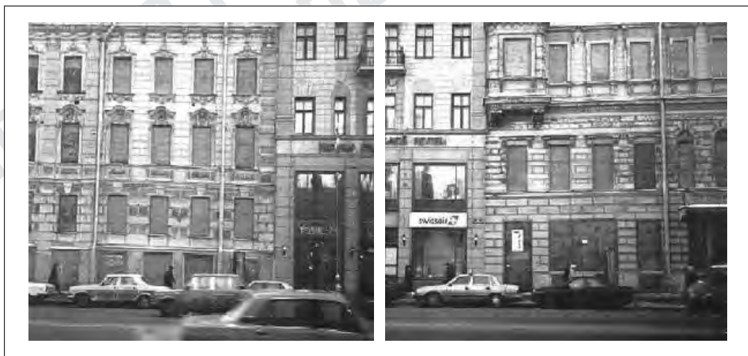
Рис. 1.6. Аварийно-деформированные дома № 55 и 59 по Невскому проспекту
