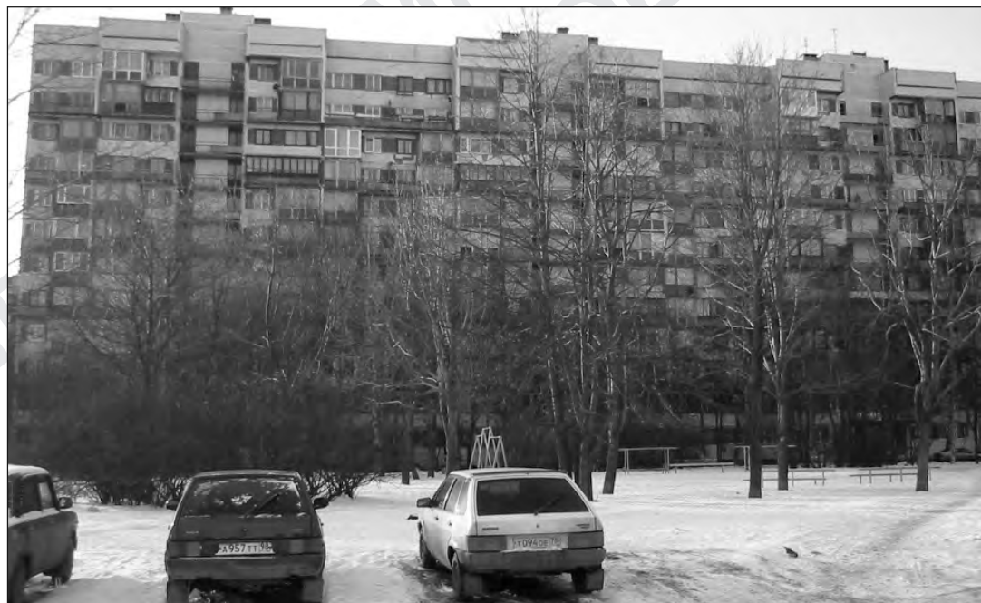
Рис. П.33. Главный фасад здания (корп. 2, 4, 6)
