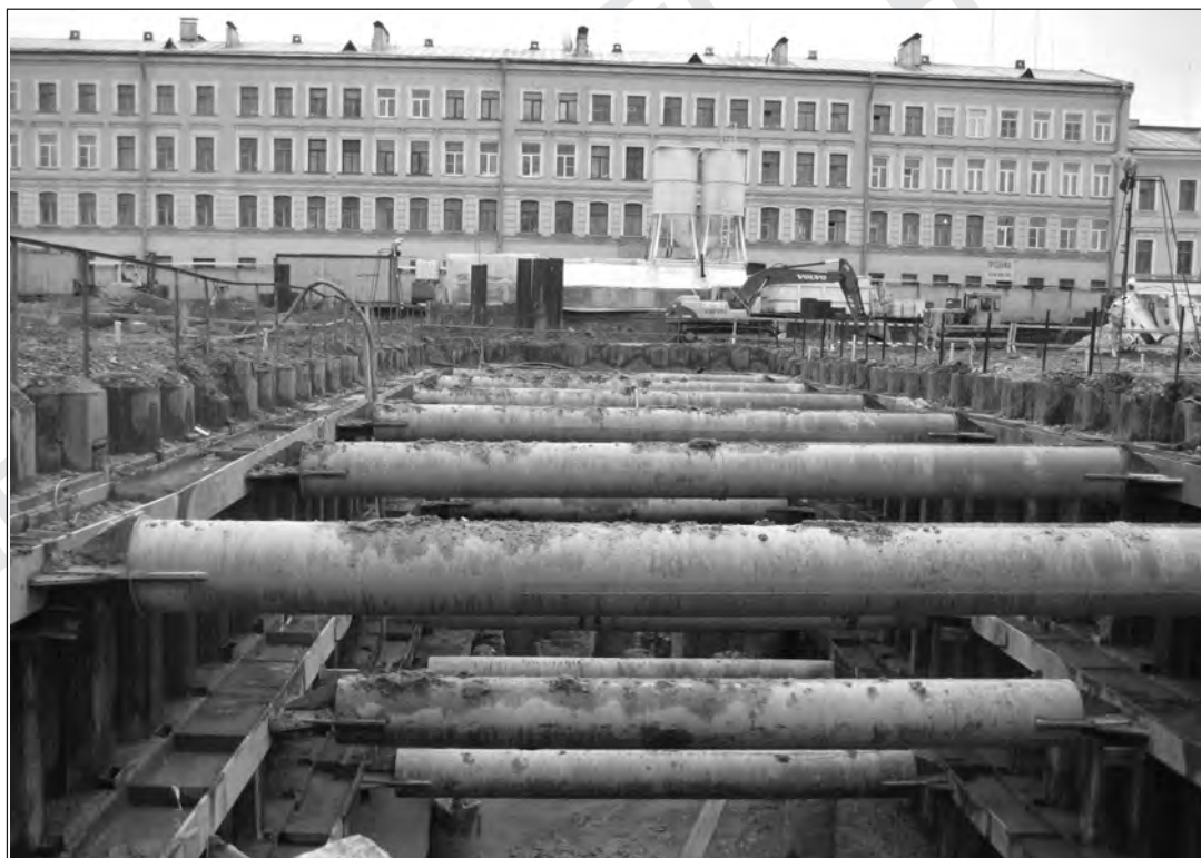
Рис. 4.22. Общий вид опытного котлована на территории строительства второй сцены Мариинского театра
