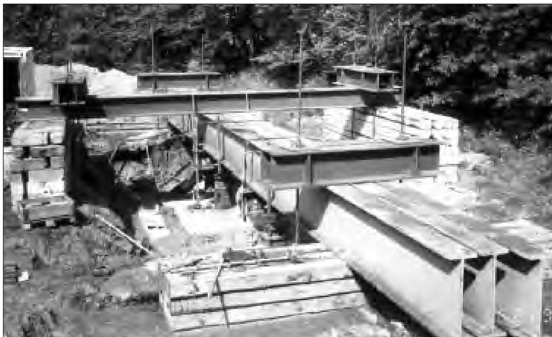
Рис. 7.13. Вид опытной площадки Tornhill в южной Швеции (исследования Шведского геотехнического института, 2001)
