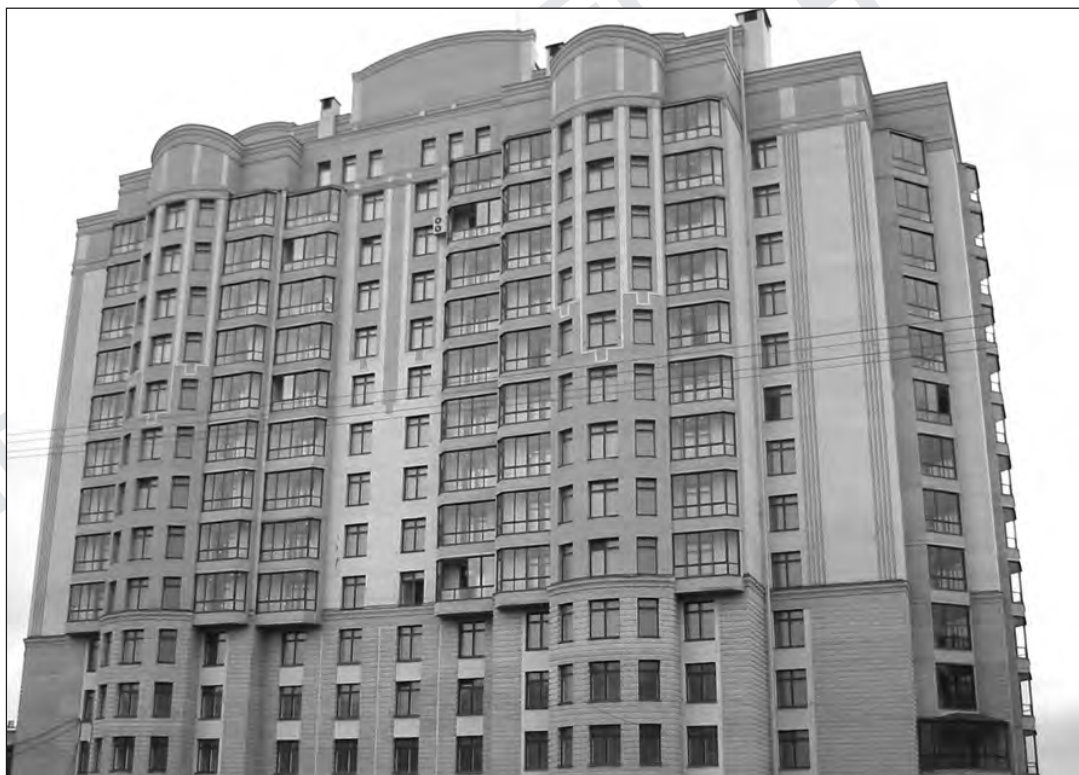
Рис. П.4. Главный фасад 17-этажного здания
