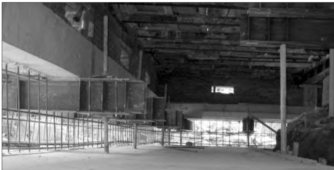
Рис. 9.10. Устройство верхней плиты на отметке -2 м
