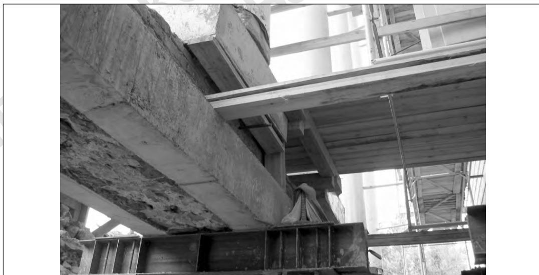
Рис. 9.8. Вся нагрузка передана на сваи, старые фундаменты разобраны
