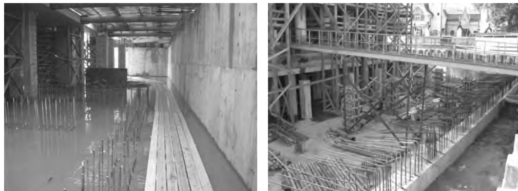
Рис. 9.15. Устройство конструкций подземного сооружения
