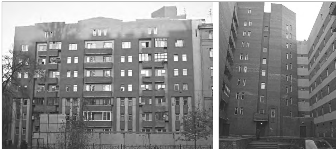
Рис. П.18. Главный фасад здания, вид здания со двора
