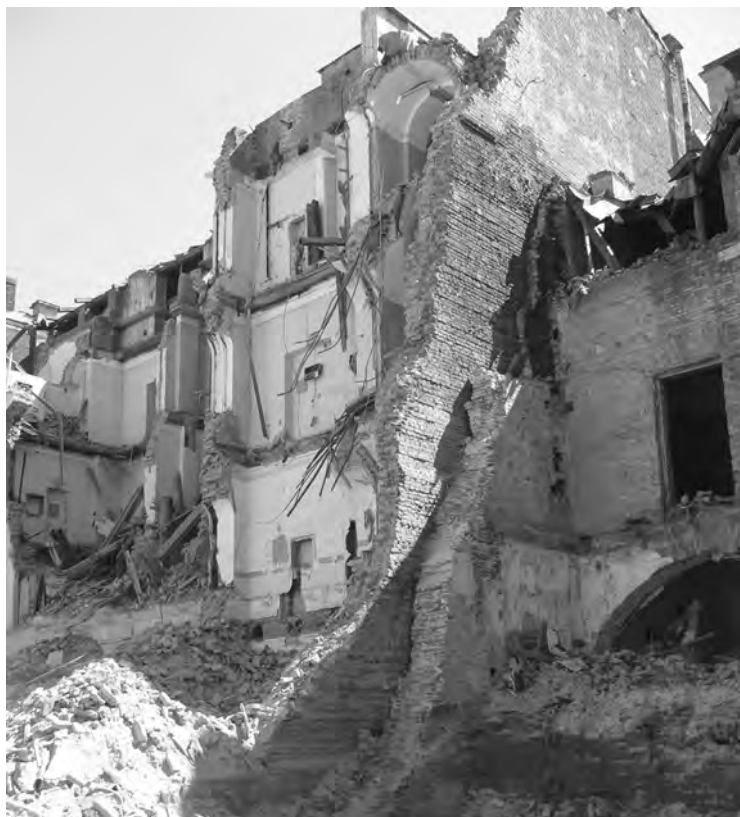
Рис. 9.36. Демонтаж конструкций внутридворовых флигелей
